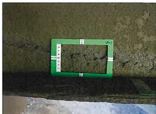
写真2 経過37年 さびの大きさが最大5mm以上、さびが剥がれかかっている
