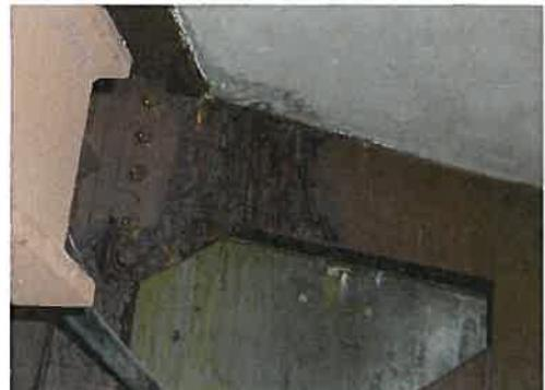
写真 4 耐候性鋼橋梁端横桁の層状はく離さび
