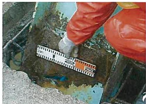
写真 2 トラス橋斜材のコンクリート床版貫通部の腐食
