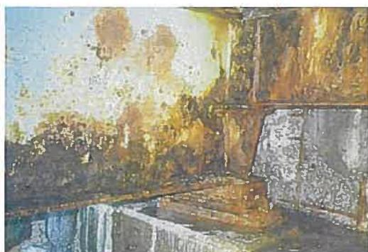
写真 1 支点部周辺の腐食
